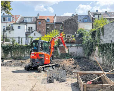
HKL steuerte unter anderem den Bagger für den Umbau des Grundstücks in Köln bei. Foto: HKL
