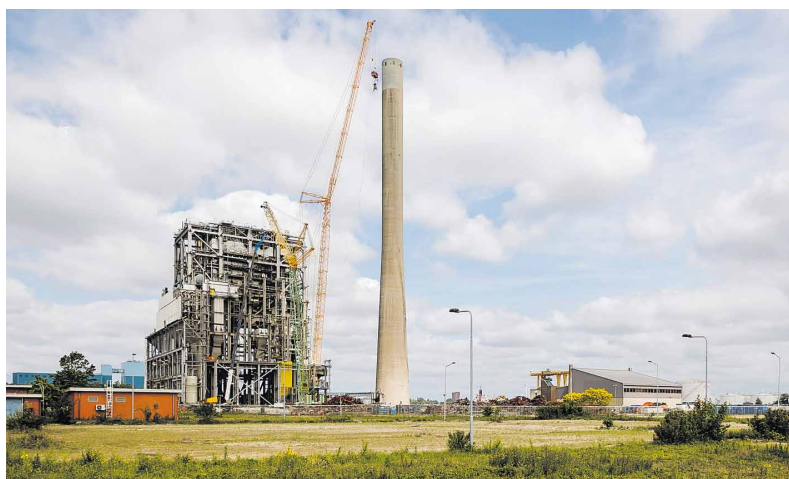
Mit einem Roboter am Haken hat der Tadano-Kran den Schornstein des Amsterdamer Kohlekraftwerks Meter für Meter abgebrochen.
