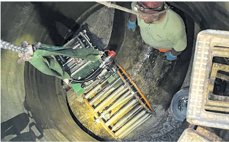
Das Einsetzen des Wickelkorbes in den Kanal ging reibungslos vonstatten.
