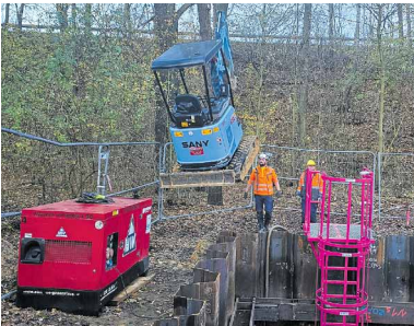
Der E-Bagger wird in die Baugrube an der A 43 in Marl hinabgelassen.
