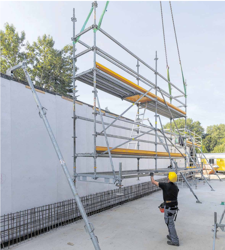
Beim Bau einer Sporthalle in Laupheim setzte das Bauunternehmen Mayer-Madel auf die Maximo-Rahmenschalung, kombiniert mit dem Peri-UP-Gerüstbaukasten.
