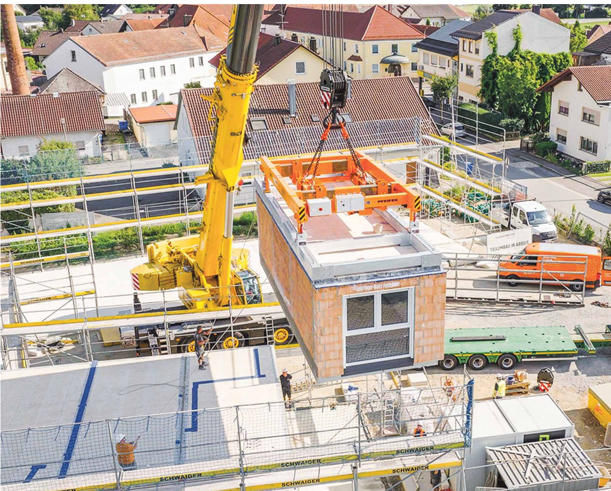
Innerhalb weniger Wochen kann der Hersteller Module für komplette Wohnanlagen produzieren. Sind sie fertig, werden sie separat gelagert und anschließend per Tieflader zu ihrem Einsatzort transportiert und mithilfe eines Autokrans montiert.
