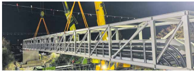
Der Einhub erfolgte im Oktober.
