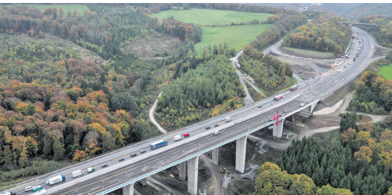
Die Brücke ist rund 22,50 Meter breit und überspannt das Tal auf 265 Meter Länge.
