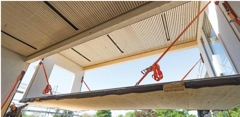
Dank der modularen Bauweise ließ sich das Gebäude in kurzer Zeit errichten.
