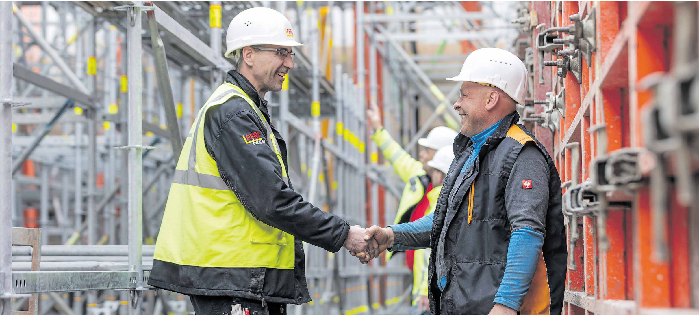
Mit Schalungssystemen, dem darauf abgestimmten PERI-UP-Gerüstbaukasten und einem zentralen Ansprechpartner unterstützt PERI Bauunternehmen dabei, Schnittstellen zu reduzieren, Verantwortung klar zu bündeln und den Baufortschritt sicher zu steuern. → Seite 16
