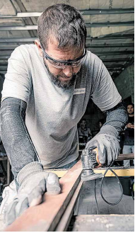
Mit traditionell handwerklichen Arbeiten kam es in Belgien zum Glasaustausch. Dabei sind auch die Lackoberflächen restauriert worden.
