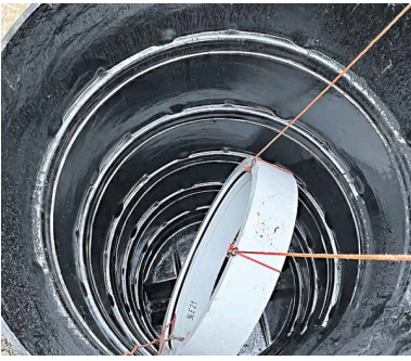
Der patentierte Adapterring.
