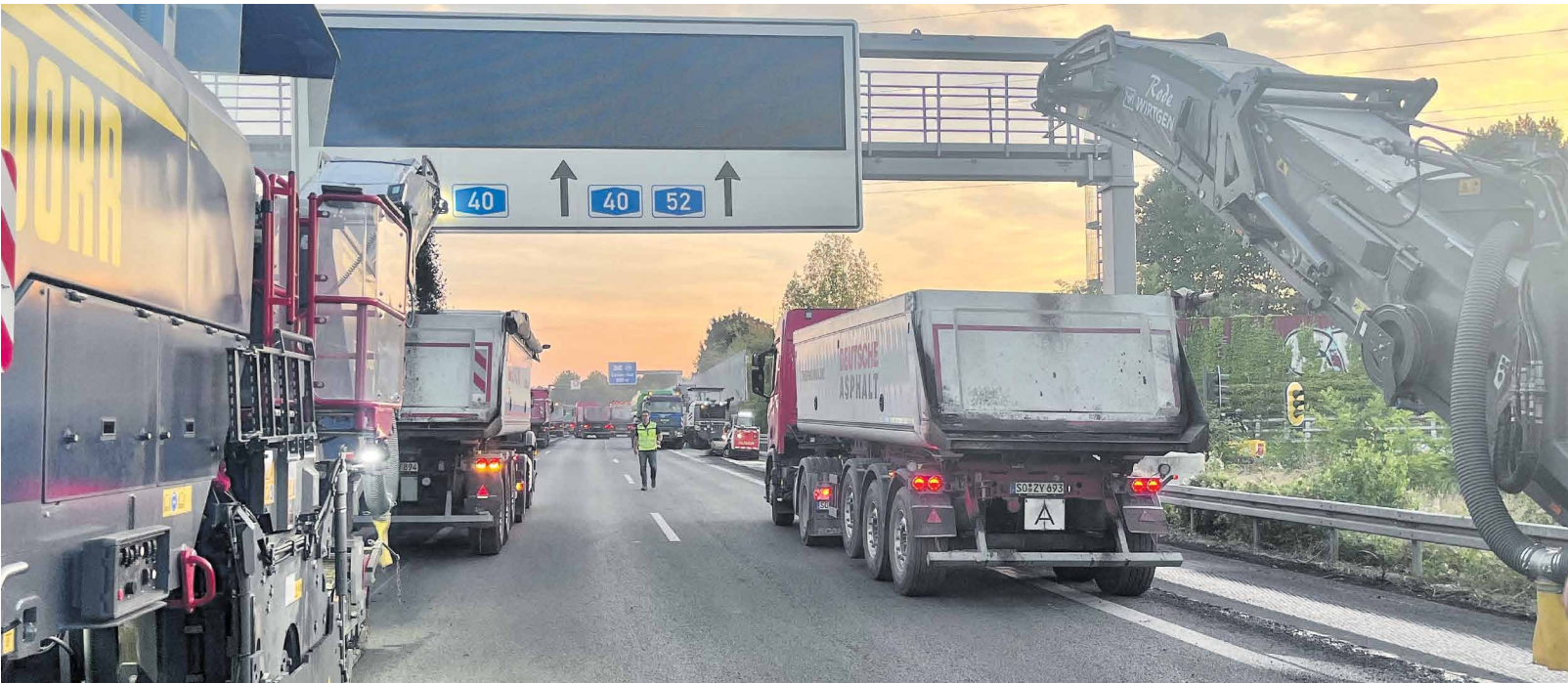
Der Einbau erfolgte innerhalb von nur sieben Tagen mit gestaffelt fahrenden Fertignern.
