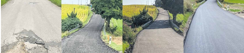
Die zuvor löchrige Strecke erhielt Asphaltfräsgut zur Verstärkung der Tragschicht (2. Bild v.l.), dann bitumenstabilisierendes Material (3. Bild v.l.), schließlich die Asphalt-Deckschicht (Bild r.).
