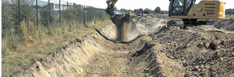
Der hydraulische Sieblöffel von Dappen gilt als leistungsstarkes, vielseitiges Anbaugerät für den professionellen Einsatz im Erd- und Tiefbau, beim Abbruch sowie dem Recycling.
