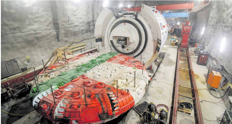
Vor dem Vortriebsstart im Juni 2023 ist „Lilia“ in einer Kaverne montiert worden.
