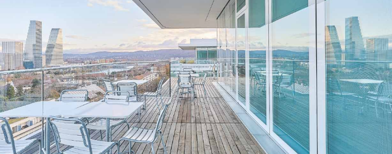
Für die Attikageschosse sind Rundumverglasungen mit raumhohen Türen eingebaut worden. Die beiden Türme (Bild unten) sind mit einem Auditorium verbunden.
