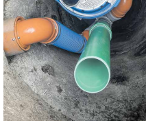
Die Anlage arbeitet nach der aktuellsten Regel des Verbands DWA „A 138-1“.
