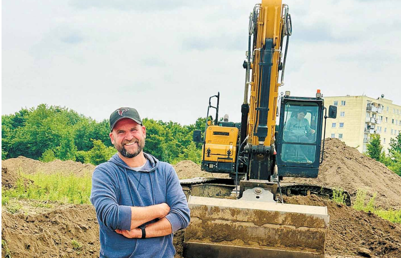
Archäologe Stefan Ciesielski und der Sany SY215C bei den Ausgrabungen in Kerpen.
