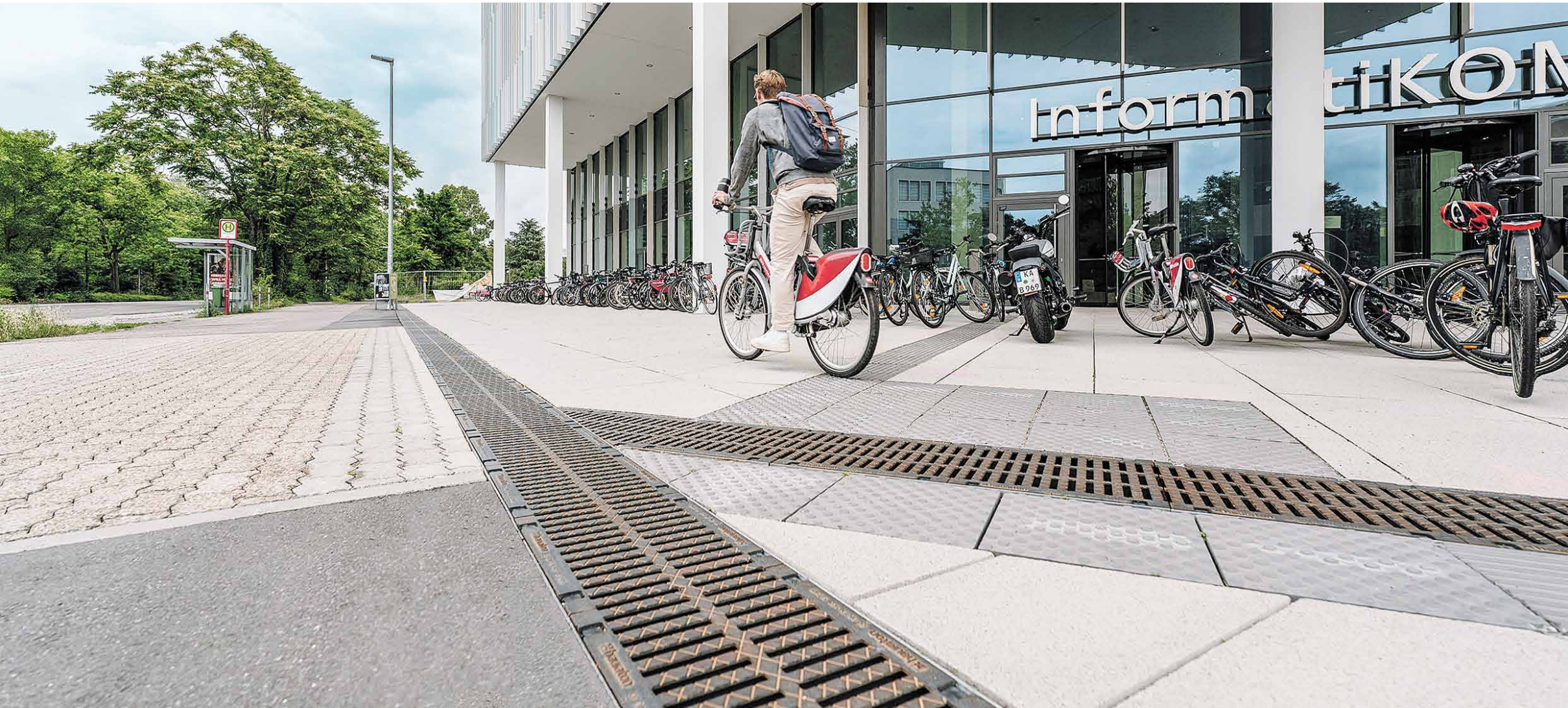
Hauraton liefert ein vernetztes Regenwassermanagement für das neue „InformatiKOM“ in Karlsruhe. Wartungsarme Filterrinnen und Rigolen sorgen für saubere Versickerung direkt vor Ort. Ein Projekt für ressourcenschonendes Bauen. → SEITE 17
