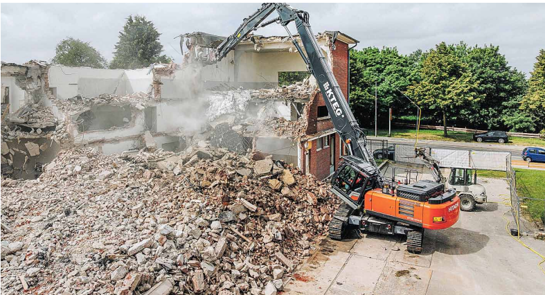
Das hydraulisch ausfahrbare Fahrwerk des KTEG 390HR-7 ist besonders standfest.
