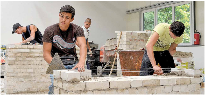
Auszubildende des Bauhandwerks auf dem Lehrbauhof der FG Bau in Berlin. Foto: Lehrbauhof Berlin/FG Bau
