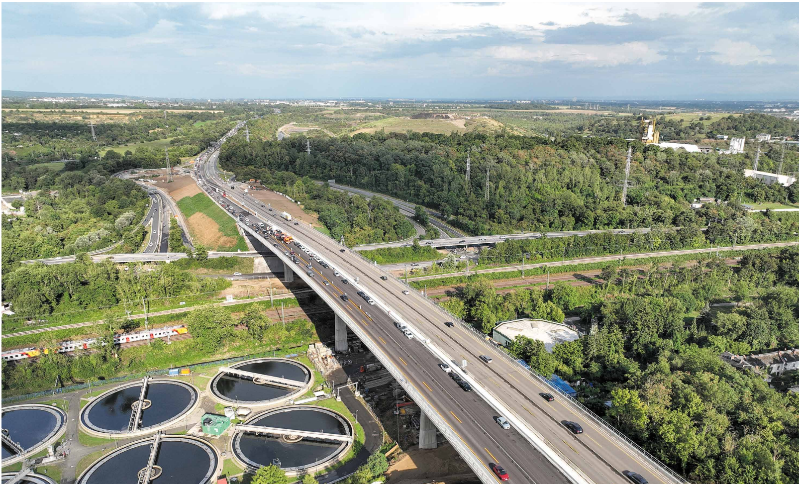
Eine mehr als vier Jahre lange Sperrung der Salzachtalbrücke auf der A 66 bei Wiesbaden ist im August zu Ende gegangen. Nun ist auch der nördliche Teil des 324 Meter langen Neubaus für den Verkehr freigegeben worden. Auf Sperrung folgten Abriss und Neubau: Unterhalb der Brücke hatte ein Passant 2021 Betonbrocken gefunden und die Behörden alarmiert.
