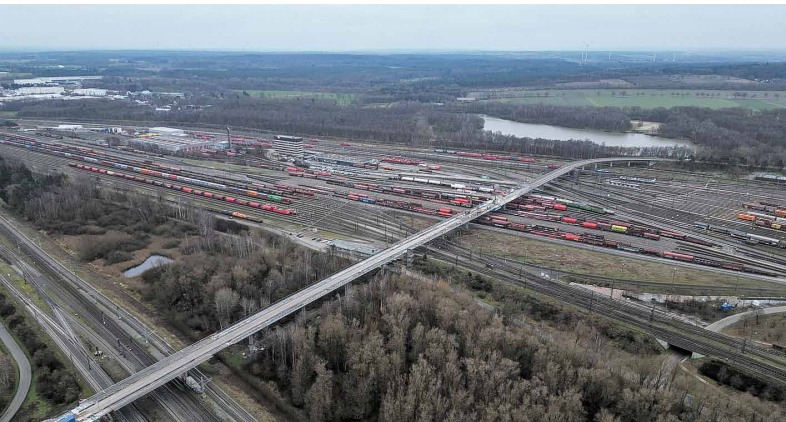
Herausforderndes Sanierungsprojekt: Die 750 Meter lange Decatur-Brücke in Seevetal (Niedersachsen) soll im Jahr 2026 wieder für den Verkehr freigegeben werden.
