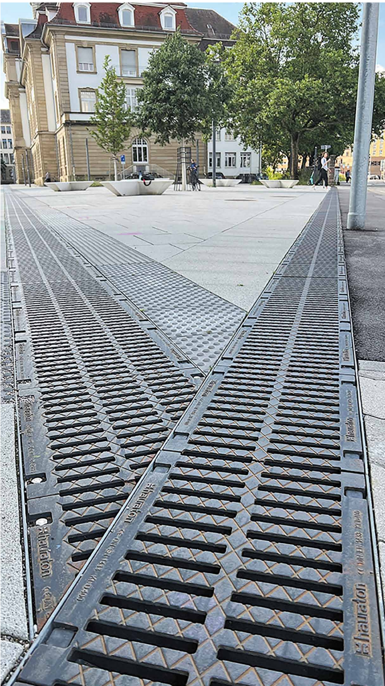
Vor dem Gebäudekomplex des KIT sind insgesamt 500 Meter Rinnen verlegt worden. Foto: Hauraton
