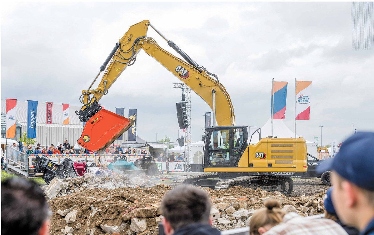
In der Anbaugeräte-Arena auf dem Karlsruher Messefreigelände wird den Fachbesuchern demonstriert wie moderne Kreislaufwirtschaft funktioniert: Vom Abbruch bis zur Verarbeitung der wiederverwendbaren Baustoffe bleibt thier nichts dem Zufall überlassen.
