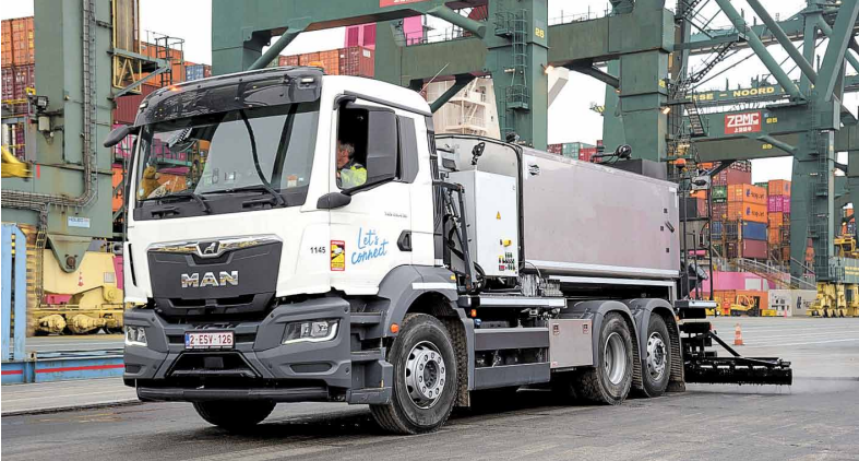
Die rechnergestützte Dosierautomatik „WeiroSpraycontrol“ gewährleistet bei der Lkw-Vorspritzmaschine die Genauigkeit der Emulsionsmenge.
