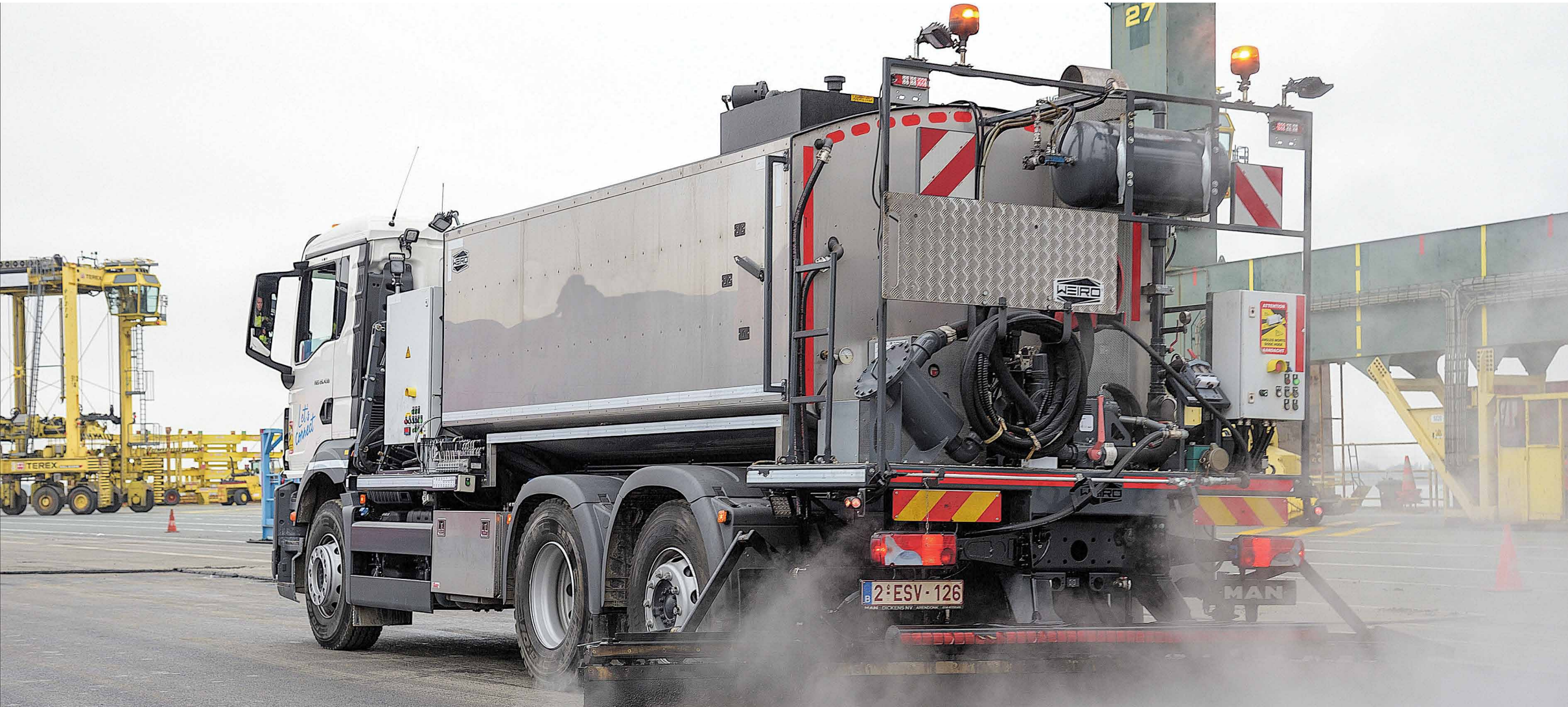
Die Anspritzmaschine „Weiro HK 1000 PH“ im Einsatz im Containerhafen von Antwerpen: Zum Ausbringen der Emulsion verfügt die Maschine über eine beidseitig hydraulisch ausfahrbare Rampe. → SEITE 10
