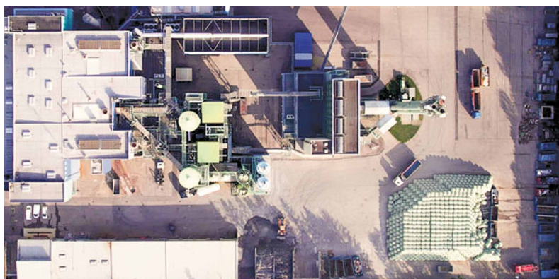
Auf dem Heizkraftwerksgelände in Geiselbullach beginnen die Bohrungen im Dezember. Foto: GfA
