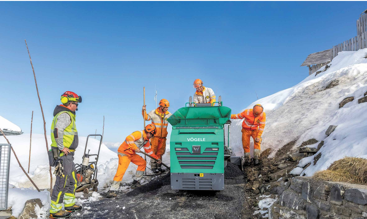
Einbau der neuen Deckschicht auf dem Schweizer Niesen bei schwierigen Bedingungen wie Eis, Schnee und Wind.
