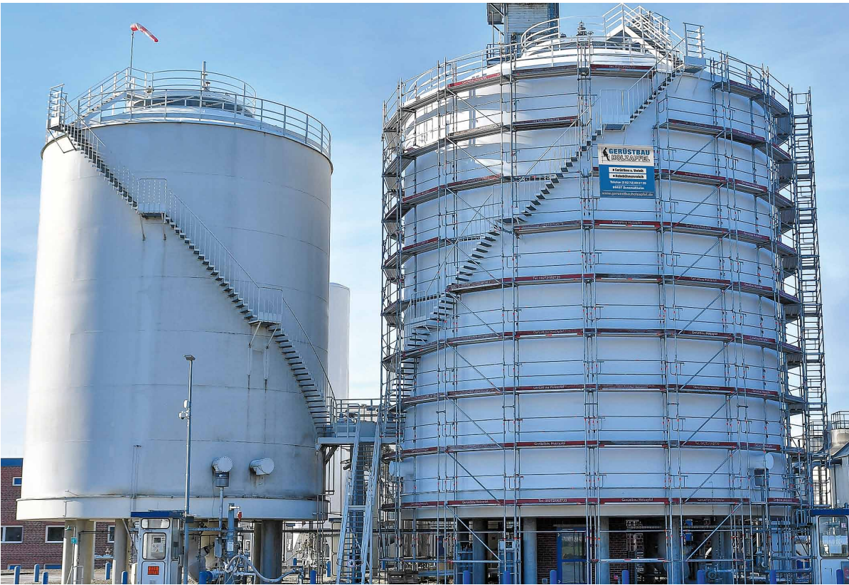
Die Außentreppe mussten in die Gerüstkonstruktion integriert werden. Das ließ sich dank digitaler Vorplanung präzise umsetzen. Foto: Wilhelm Layher GmbH
