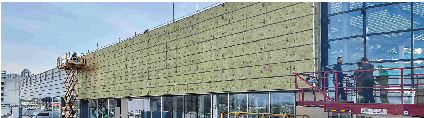
Auf einer zu dämmenden Gesamtaußenfläche von 2.000 Quadratmetern kamen Erzeugnisse des Dämmsystem-Herstellers Ursa zum Einsatz.
