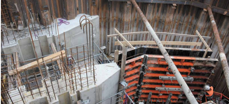
Vor dem Einsatz der Wandschalung kamen Spundwände in den Gewässergund.
