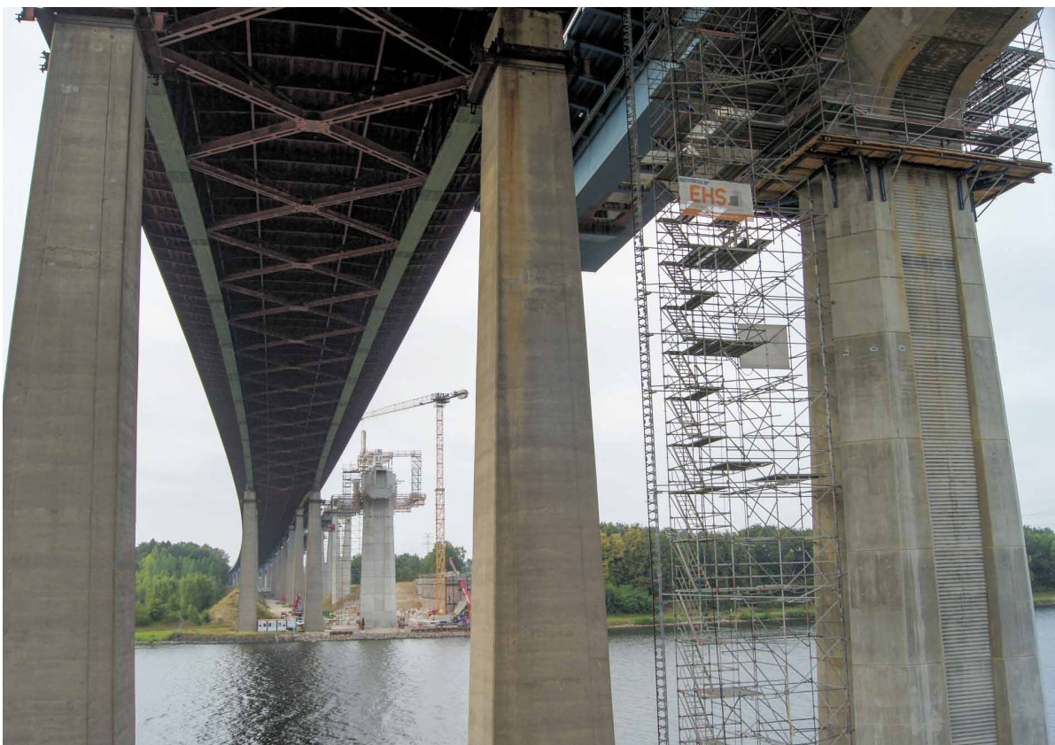
Gleich daneben: Um den Verkehrsfluss nicht auszubremsen, wird die Rader Hochbrücke direkt neben der alten gebaut. Riffelungen und variierende Abflachungen an den Kanten der Pfeiler zeugen auch von einem höheren ästhetischen Anspruch.
