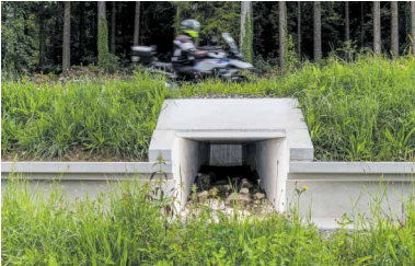
Die Durchlässe entstanden mit dem Hochleistungsbeton „C60/75“.
