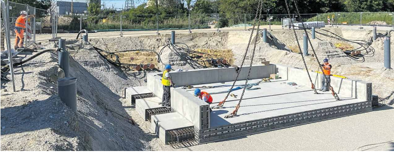
Die Montage der bis zu 35 Tonnen schweren Betonelemente erfolgte passgenau vom Kleihues-Team mit Mobilkran.
