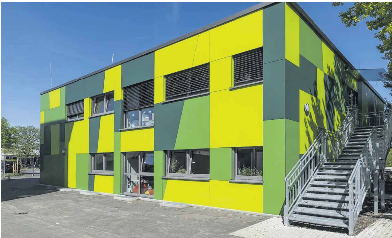
Die zweigeschossige Anlage, die bereits seit 2023 genutzt werden kann, entstand in Containerbauweise und umfasst eine Größe von 18,15 x 15,68 Metern. Foto: Losberger De Boer
