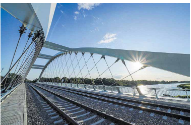
Die neue Bahnbrücke über die Oder bei Küstrin im Land Brandenburg. Foto: Deutsche Bahn/Emerleben
