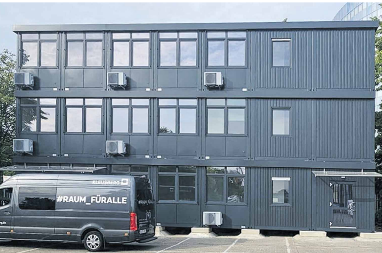
Insgesamt 608 Einheiten werden für die Interimslösung in Düsseldorf verbaut. Foto: Kleusberg
