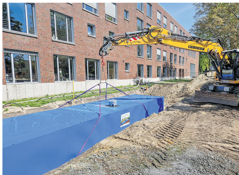
Im Zuge des geplanten Erweiterungsbaus für das Maria-Sibylla-Merian-Gymnasium ließ die Münsterländische Stadt Telgte auch die Regenentwässerung erneuern. Foto: Funke Kunststoffe
