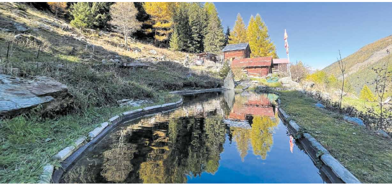
Das erfolgreich abgedichtete Gewässer steht exemplarisch für die Stärken von InnoElast Typ 2.
