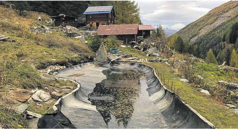
Nach einer Woche Materialaushärtung konnte der See befüllt werden.
