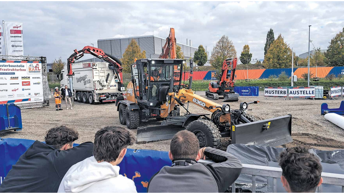
Neu im Karlsruher Messeprogramm ist die „Musterbaustelle Infrastrukturbau“ mit drei Liveshows pro Tag gewesen.
