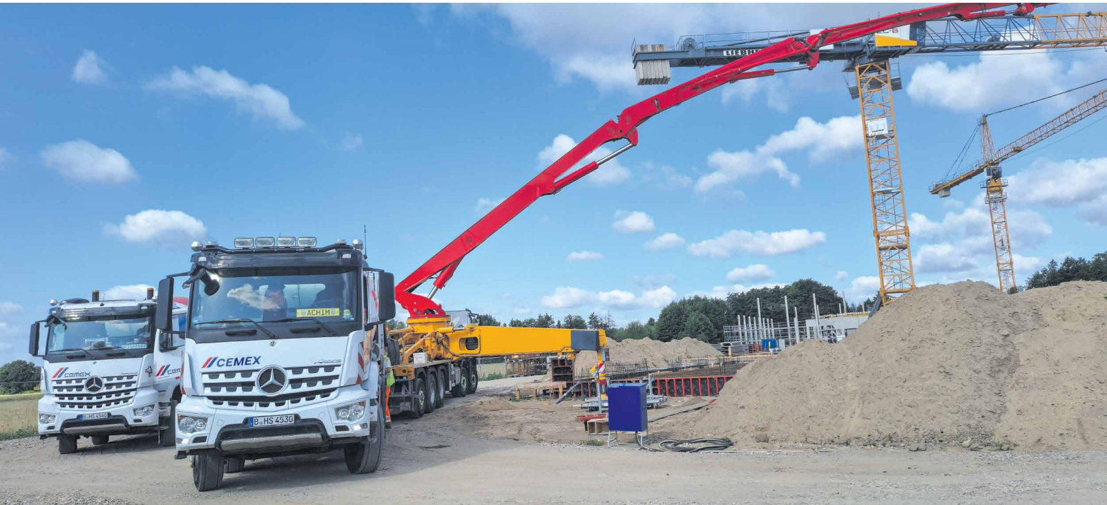
Der Baustoffhändler Cemex schickt rund 4.000 Kubikmeter Vertua-Beton auf die Baustelle.
