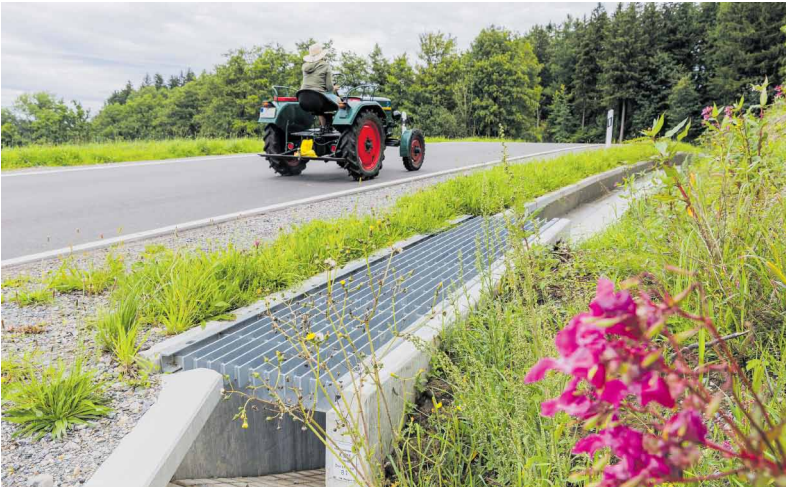
Auf der Seeseite wurde entweder eine gekrüpfte Durchlassöffnung gewählt oder ein Portalelement mit versenktem Einstieg und Abdeckgitter eingebaut.
