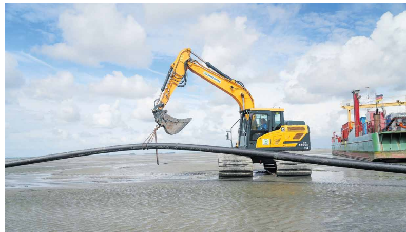
Dem 14,4-Tonner ist kein noch so langes Kabel zu schwer.
