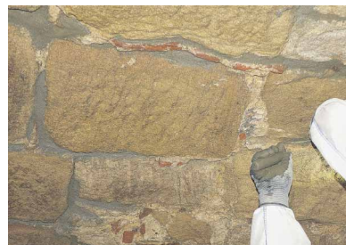
Lockere Fugen sind mit dem Trassmörtel von Hand stabilisiert worden. Fotos (2): Güteschutz Kanalbau
