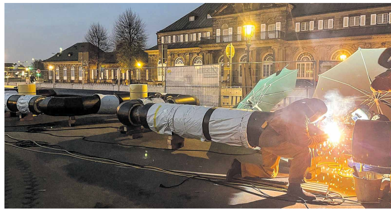
300 Schweißverbindungen waren bei der Leitungsverlegung nötig. Foto: Ludwig Pfeiffer
