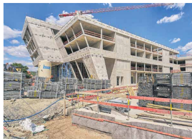
Die Überhangfassaden bildeten eine besondere Herausforderung bei Planung und Ausführung.
