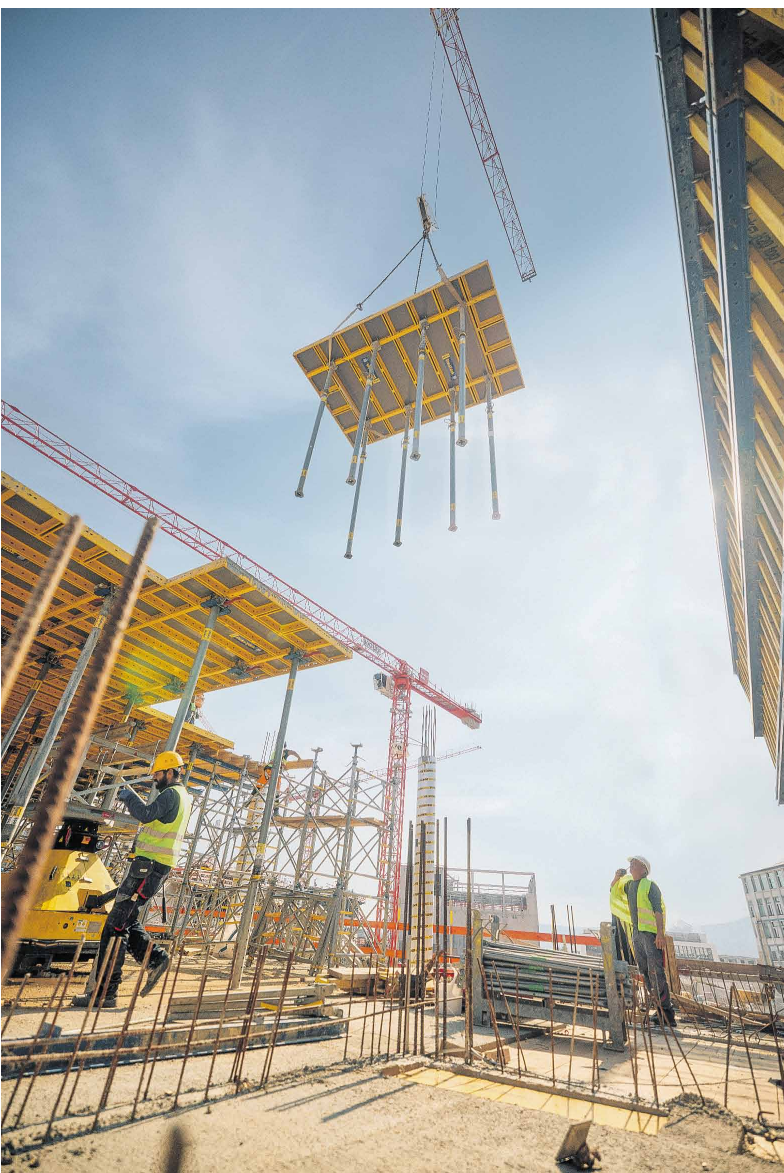
„DokaXdek“-Tische lassen sich mit einem Kran schnell zusammensetzen.
